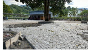
Steinplatz fast Fertig
